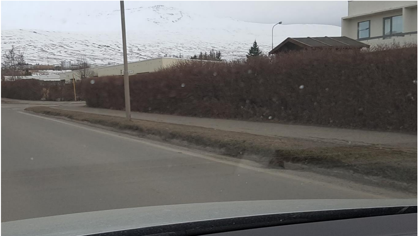
Þingvallastræti, 28.3.2018. Drullan hefur hlaðist upp árum saman og nær hátt upp fyrir kantsteininn.
